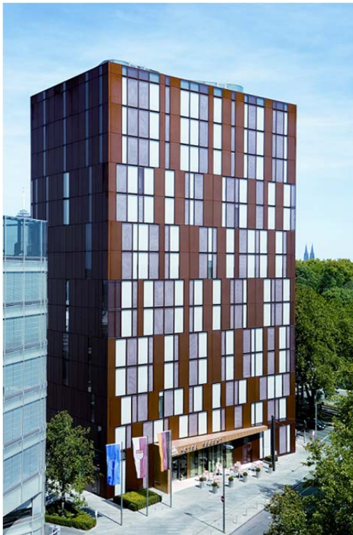
Außenansicht des „Ameron Regent“ in Köln
